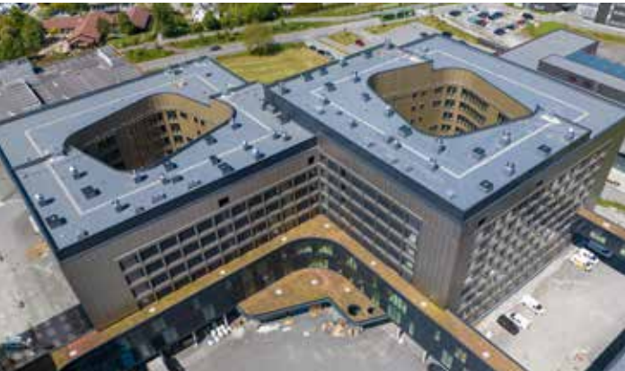
SETT FRA LUFTEN: Fra luften er er atriums-åpningene karakteristiske. Innomhus vil et avrundet rundt hjørne gi bedre oversikt mot korridorene. Det virker faktisk! Foto: Helse Stavanger.
