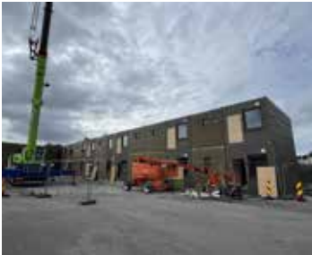
FLYKTNINGEBOLIGER UNDER BYGGING: Heiamyrå på Gausel.
